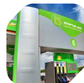
Zewnętrzne fragmenty stacji paliw
